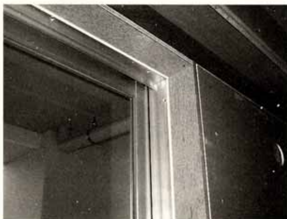
上 クロス巻き込みの窓枠仕上がり後
